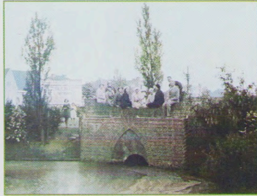
Architect Warners, rechts met zijn benen over het muurtje, geeft een gezelschap tekst en uitleg op zijn brug. Circa 1929.
